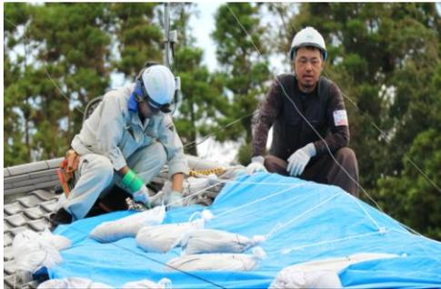
被災して雨漏りする住宅屋根にブルーシートを貼る千葉土建のなかま
